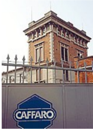
Il sito Lo stabilimento in via Milano
